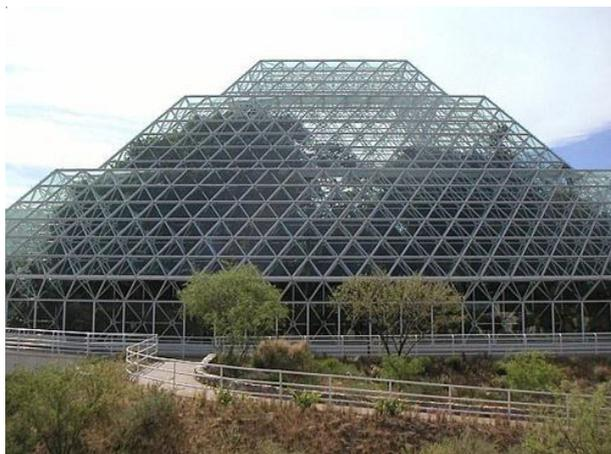
Рис. 10. «Биосфера-2» — гигантский герметизированный комплекс зданий из бетона, стальных труб и 5600 стеклянных панелей
