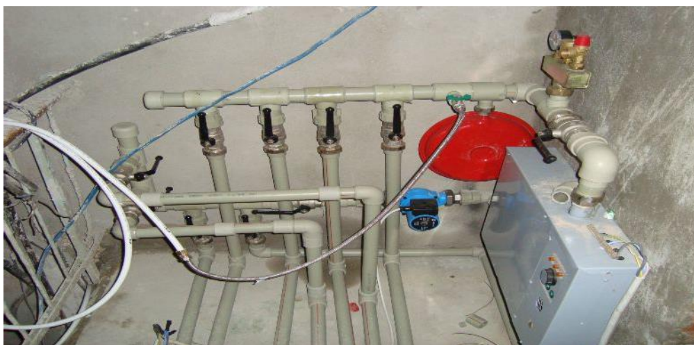
Рисунок 7.4. Обвязка трубопроводов от индивидуального котла.
